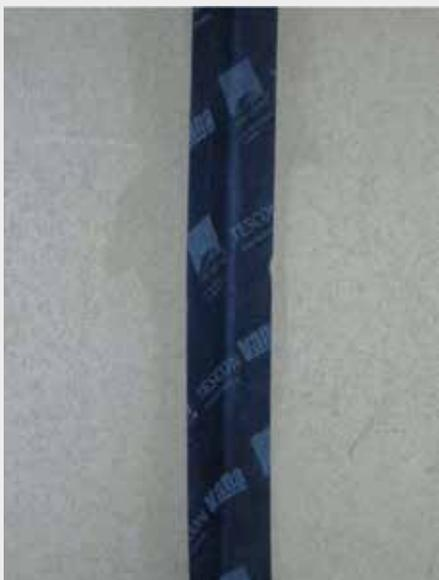
Luftdichte Abklebung einer Innenecke auf **fermacell** Vapor mit Primer
