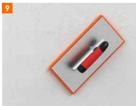
Abfilzen der Putzoberfläche mit einer Schwammscheibe
