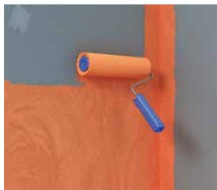
**fermacell** Flüssigfolie mit der Rolle 2×vollflächig auftragen (Gesamtdicke  $\geq$  0,5 mm), Trocknungszeit: 2 Stunden, Anstrich: ca. 2-3 Stunden
