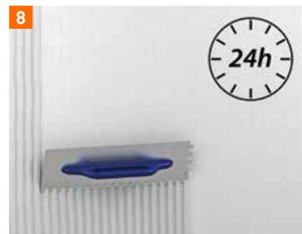
Aufbringen der zweiten Putzschicht 2–3 mm **fermacell** HD Leichtmörtel nach Erhärten der Armierungsschicht (Variante A)
